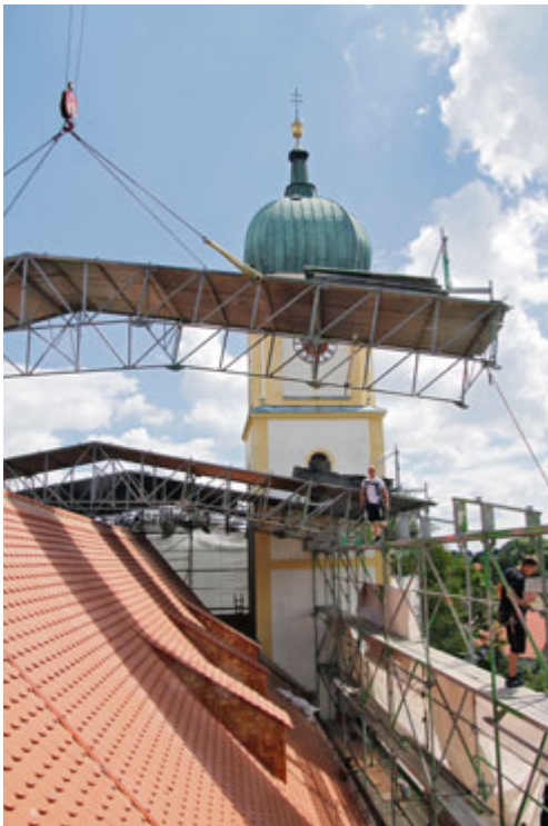
Das Abheben des Schutzdaches
