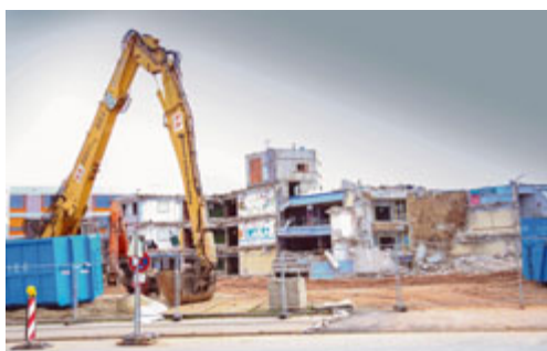
Aufwendigere Abrissarbeiten der alten Realschule wegen Asbestfund
