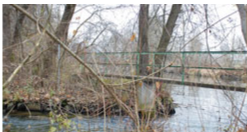
Der Steg über den Schwebelbach ist einer der vier Brücken, die abgerissen werden sollten
